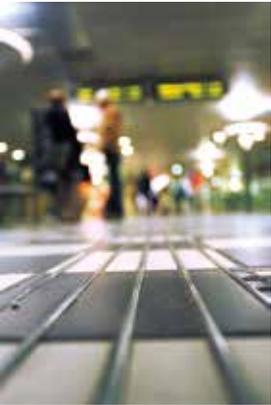
Ein deutlich markierter Hell-Dunkel-Kontrast hilft sehgeschädigten Fahrgästen, die Bahnsteigkante zu erkennen. Blinde Fahrgäste können sich über tastbare Streifen am Bahnsteig orientieren. Einige neue und umgebaute Haltestellen haben darüber hinaus auch tastbare Pfeile an den Geländern, die bei der Orientierung helfen.
